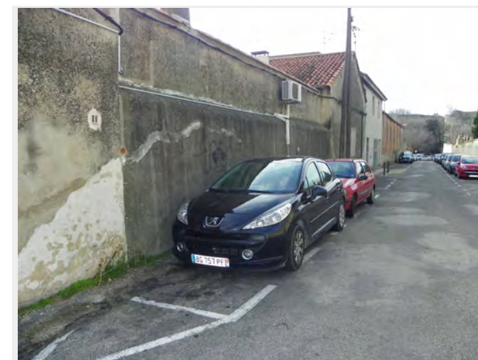
Un front de bâti non cohérent
