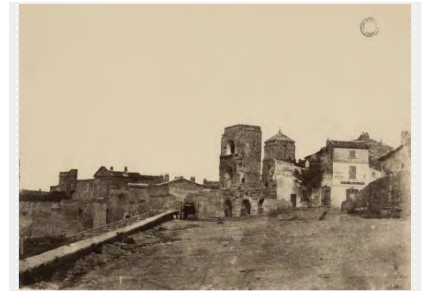
Vue ancienne (source: bibliothèque d'Arles)
