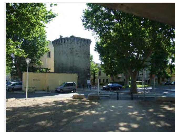
Édicule bâti accolé à la tour
