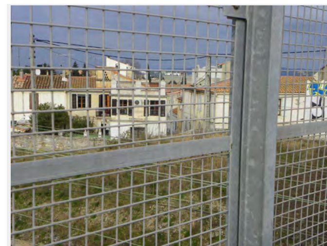
Un garde corps qui obstrue la vue
