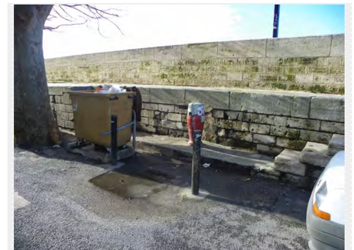
Éléments empêchant l'accès au quai
