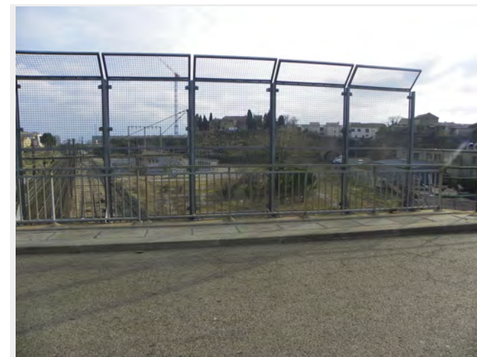
Garde corps du pont
