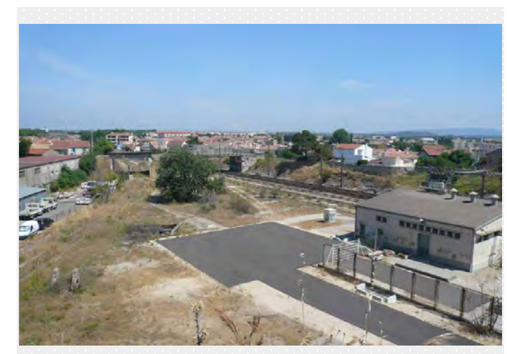
Suppression du transfo EDF à envisager
